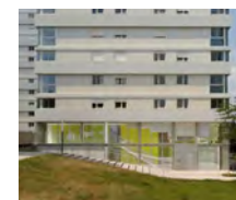
RÉHABILITATION D'UNE TOUR - ROUEN GRAN MARE, BMC2
